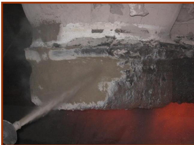
**Эти разбрызгиваемые массы наношены полусухим методом. Они обеспечивают возможность быстрого ремонта повреждений огнеупорной футеровки во время эксплуатации тепловых агрегатов. Ремонт происходит главным образом между последующими плавками..**
